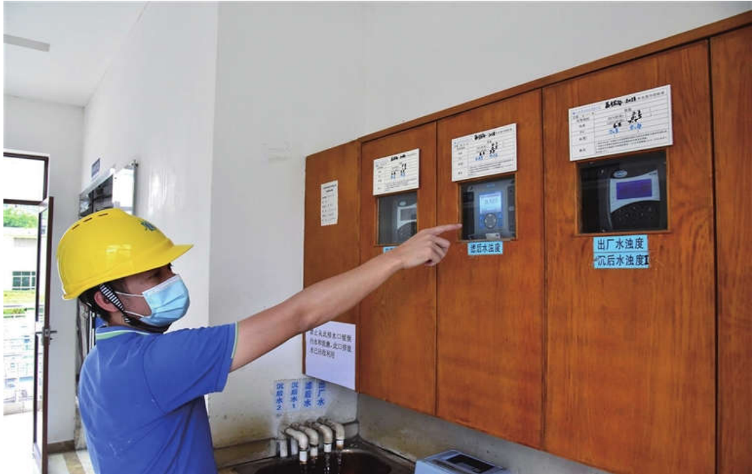
荔枝沟水厂的工作人员在查看滤后水浊度表。记者刘琪成摄
