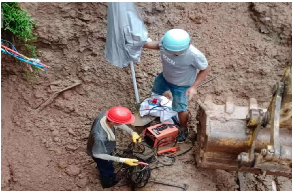
确定漏水位置后，管网部立即组织抢修队入场抢修，为了最小程度减少抢修影响，抢修人员历时一个多小时的开挖，挖掘出近 25 平方米、深近 5 米的作业基坑后，漏水管道才被开挖出来。确定管道漏水位置及漏水原因，抢修队立即关阀停水，经过 5 小时不间断的抢修，终于把漏水管道修好，恢复了该供水辖区的正常用水。（管网部 盛洲）
