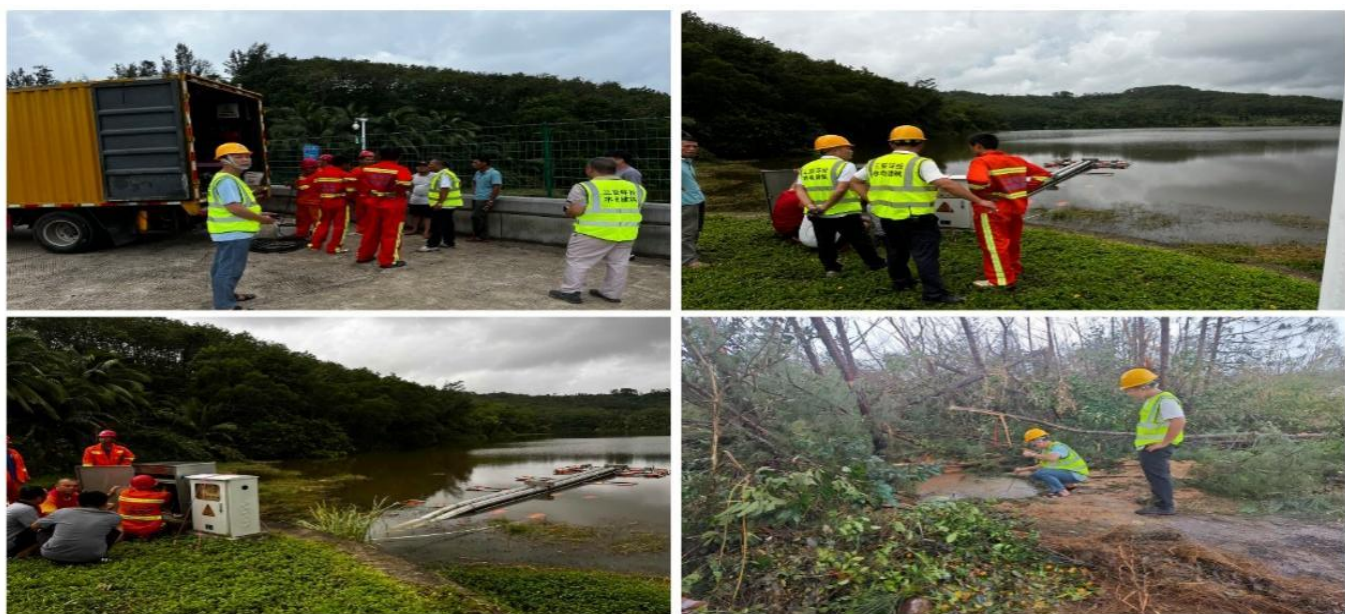
水西水库原水取水泵抢修、下坡村 PVC200 管探探漏抢修
