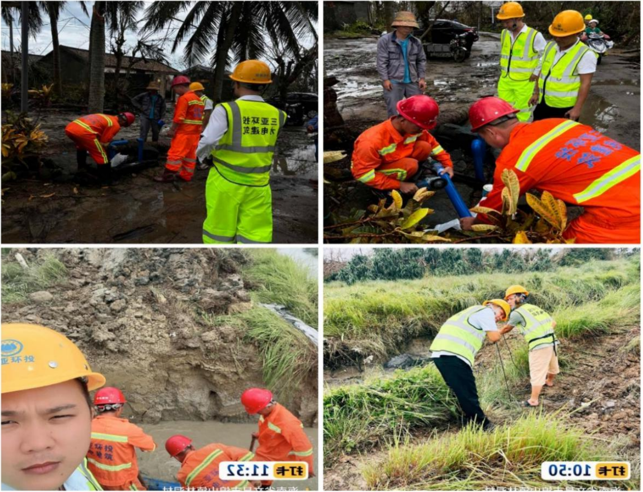
吴茶仔小区 PVC63 供水管抢修、谭龙村 PVC200 供水管探漏抢修
